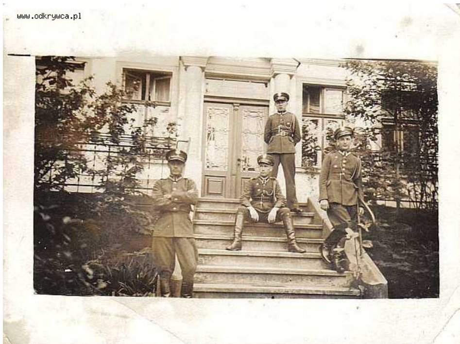
Fot.: żandarmi na tle budynku, gdzie mieścił się posterunek Gdynia-Miasto 14
